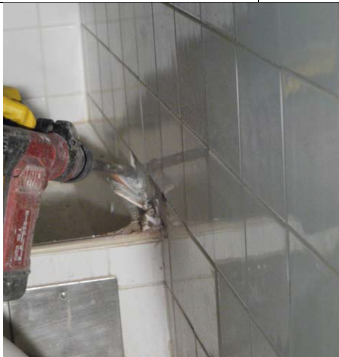
Abbildung 1-20 vorsichtiges Entfernen der angrenzenden Fliesenscharen (Quelle: eigenes Bild)
