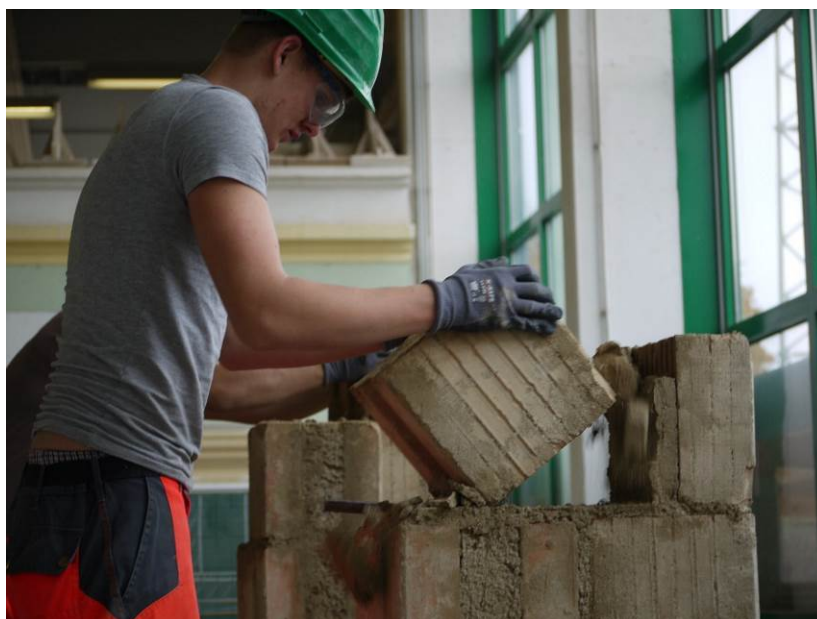
Abbildung 1-9 Lösen des Einzelsteines aus dem Verband
