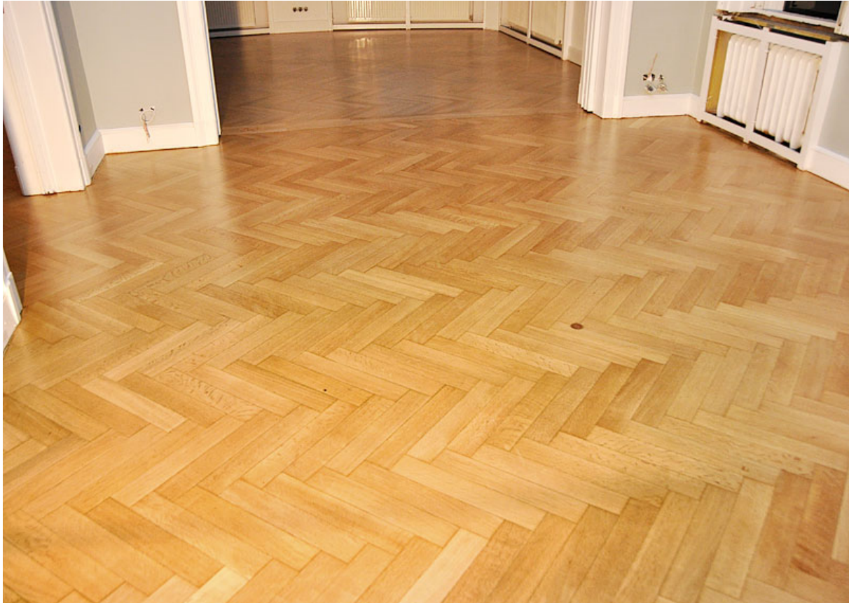
Abbildung 1-29 Eichenparkett Natur, auf Blindboden im Fischgrätverband genagelt, Oberfläche geölt und gewachst 42
