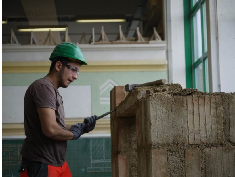
Abbildung 1-8 Lagerfuge abbrechen
