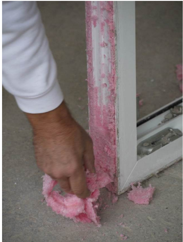
Abbildung 1-5 Montageschaum entfernen
