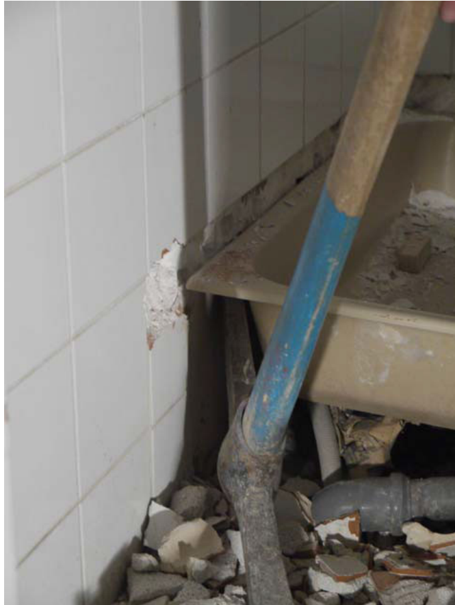
Abbildung 1-21 Aushebeln der Duschtasse mit Pickel (Quelle: eigenes Bild)
