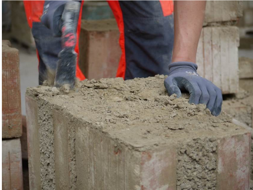
Abbildung 1-10 Abschlagen des Mörtels
