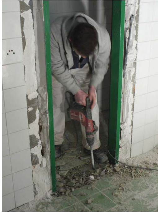
Abbildung 1-13 Ausstemmen einer Stahlzarge mit leichtem Elektrohammer
