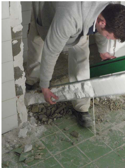
Abbildung 1-14 Herausnehmen des Türstocks aus der Zwischenwand
