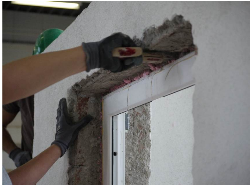
Abbildung 1-3 händisches Durchtrennen der Montageschaumfuge
