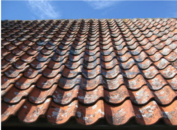
Abbildung 1-22 Eindeckung mit Tondachziegeln. 29
