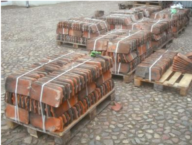
Abbildung 1-23 Geworbene Dachsteine auf Paletten für den Abtransport vorbereitet 34
