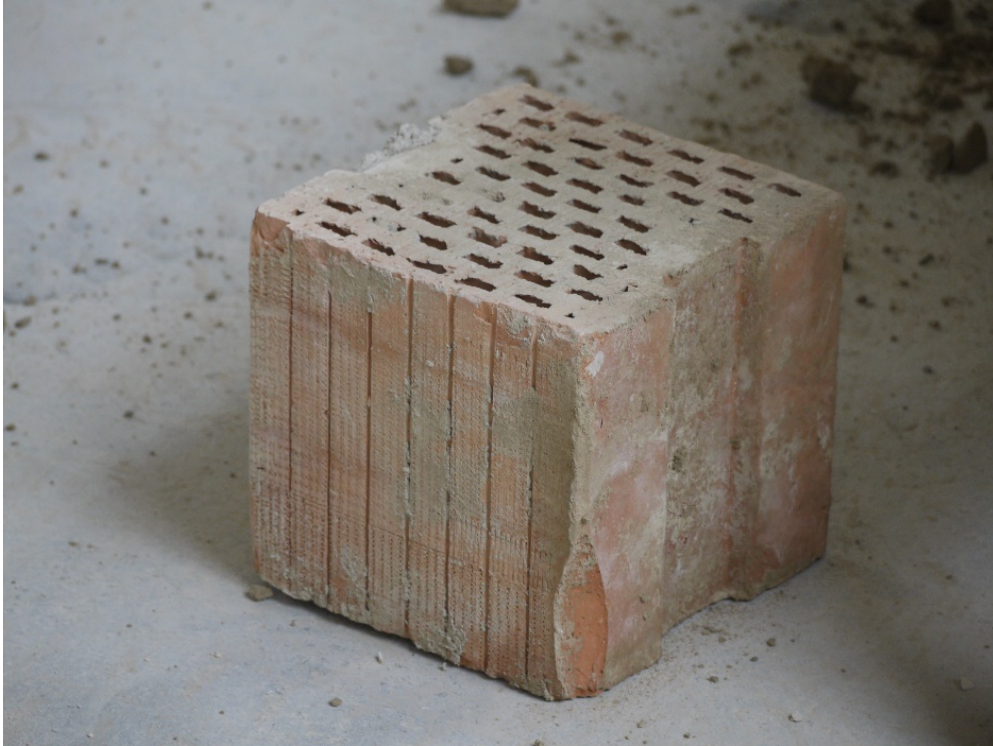
Abbildung 1-7 Rückgebauter HL-Ziegel (10 Lochreihen 25/25/23,8)
