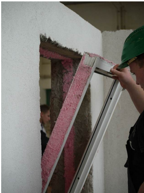
Abbildung 1-3 händisches Durchtrennen der Montageschaumfuge
