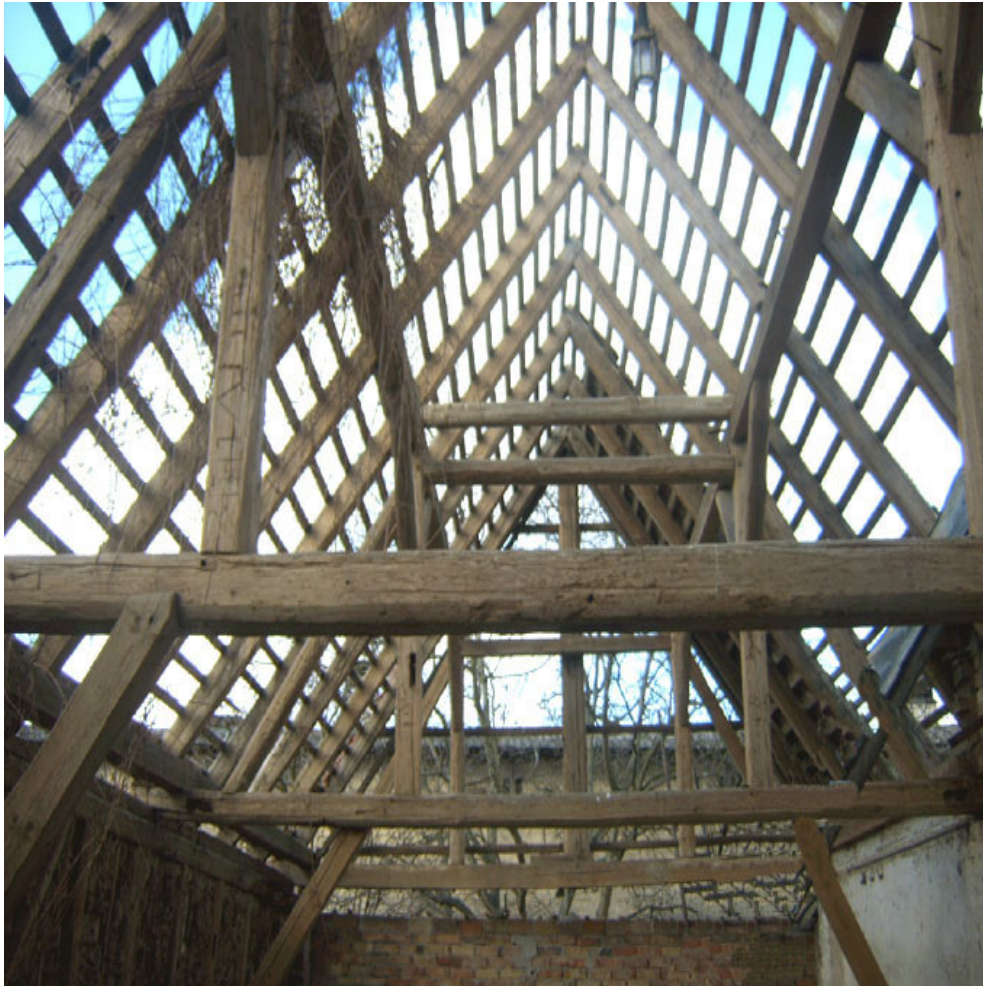
Abbildung 1-24 Sparrendachstuhl mit Fuß- und Mittelpfette und Kehlbalken 36
