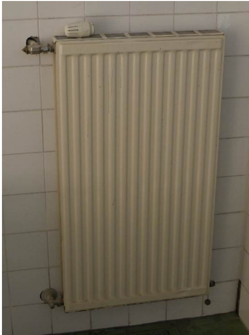
Abbildung 1-16 Zweiplattenheizkörper ohne Konvektionsbleche mit seitlichen Anschlüssen 20
