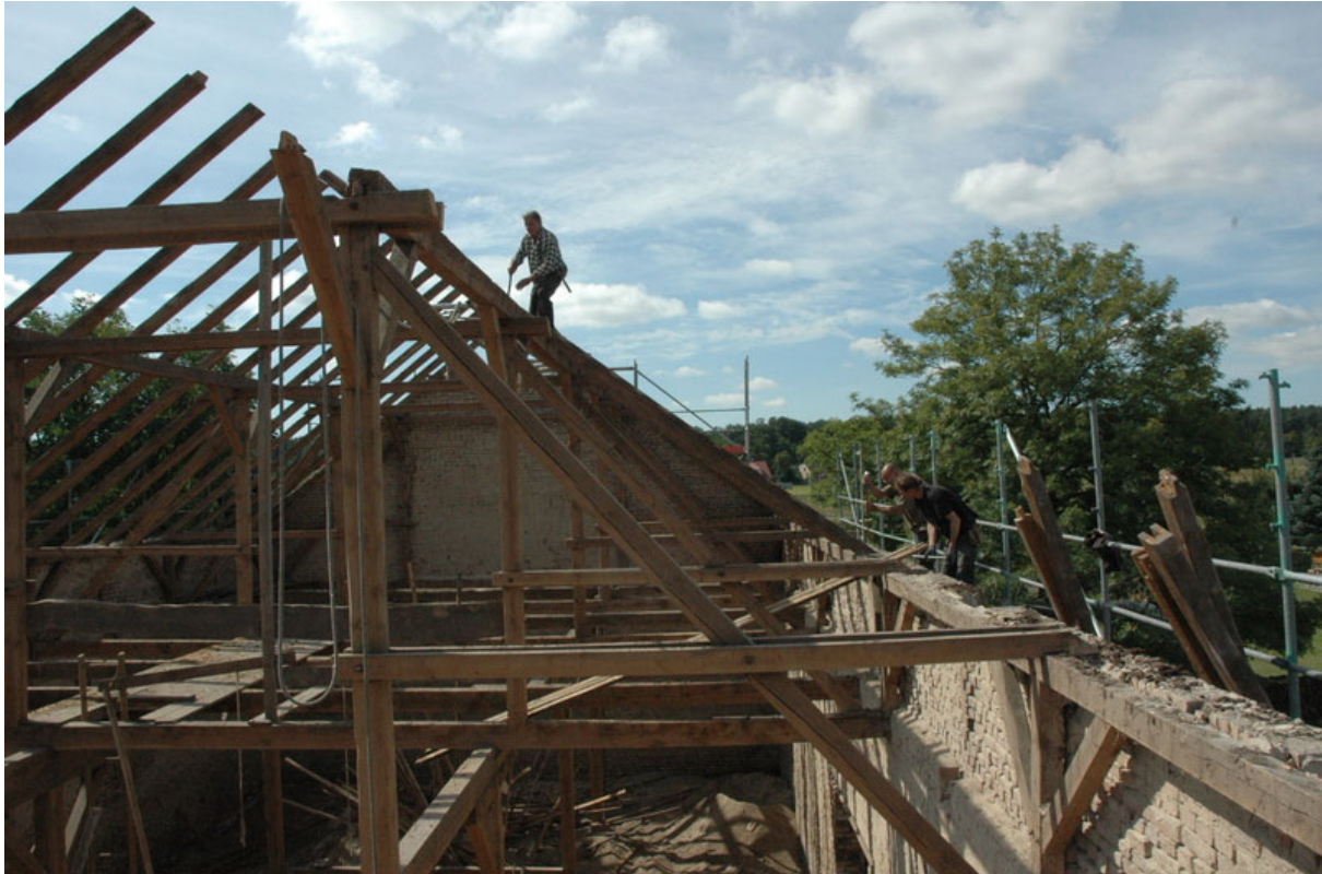
Abbildung 1-26 Freigelegter Dachstuhl - bereit für den Rückbau. 38
